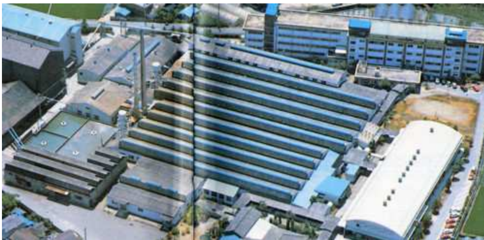
ノギリ屋根が特徴の天竜社工場。数年前に解体撤去された。(蚕と絹の歴史：飯田市立図書館所蔵)
